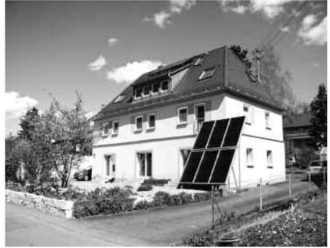
**Gebäude des Vereins in Gammertingen mit Wärmedämmung, Solarwärme, Pellets-Heizung**
